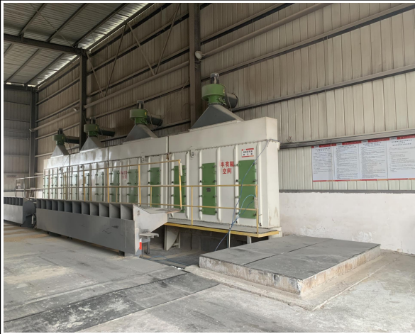
卸料车间密闭情况
